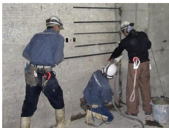
(a) 研究施設での施工
