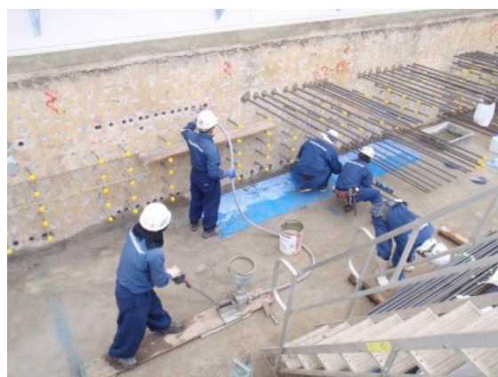
(b) 大型発電所での施工
